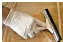
Eliminar agua sucia y restos de lijado
