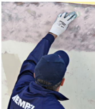
Enmasillado en la línea de flotación
