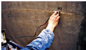
Lectura de humedad
