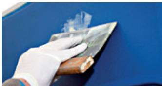
Enmasillado con el uso de una llana
