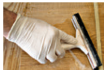
Vuil water verwijderen
