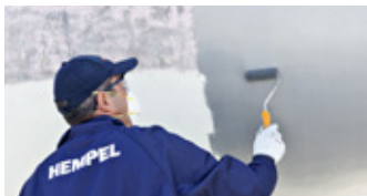
Underwater Primer opbrengen op geprepareerd oppervlak
