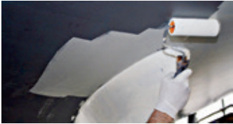
Apply antifouling over primer
