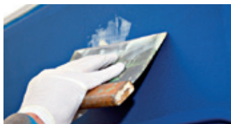
Fill using blade
