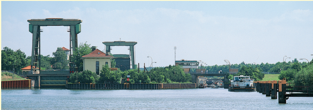
Zufahrt zum Unterwasser der Schleuse Flaesheim
