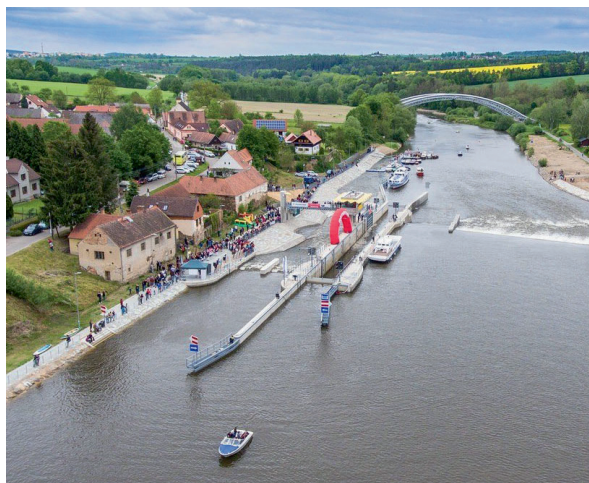
Eröffnung der Schleuse Hněvkovice an der Oberen Moldau 2017 © RVCČR
