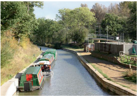
Ehrgeizige langfristige Projekte zur Kanalrestaurierung werden von den Restaurierungsgesellschaften oder Trusts verfolgt, wie hier in Loxwood am Wey & Arun Canal, wo der Trust ein Besucherzentrum gebaut hat.
