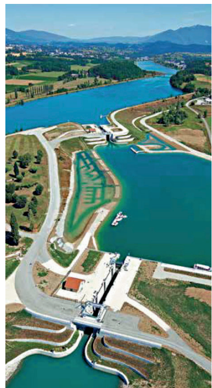
Schleusen Brens auf der oberen Rhône © CNR
